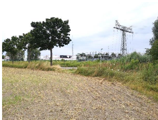
Abb. 22: Blickrichtung Kurvenbereich des Krügerweges
