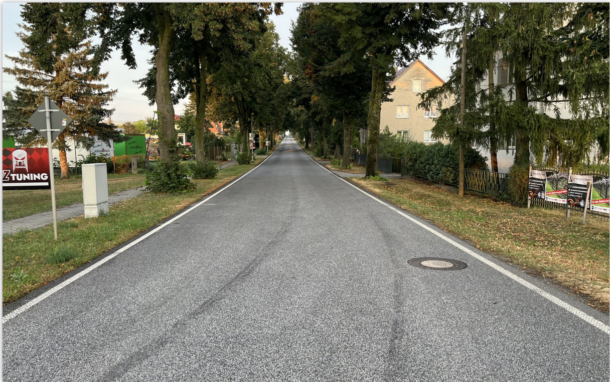
Abbildung 2-10 Zossener Straße (Blickrichtung Ost)
